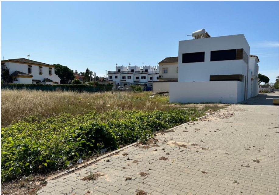
Vista del ámbito, con la edificación de la parcela 136 en primer término.
