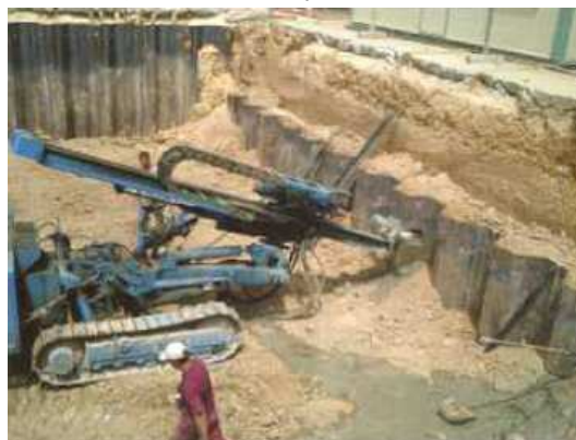
Máquina colocando anclajes
